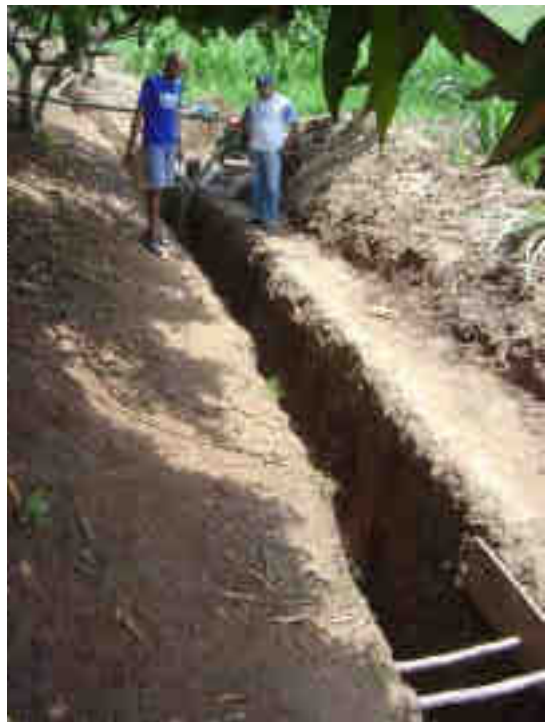
Construção de barragem subterrânea Fonte: COEP
