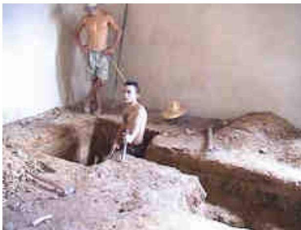
Preparação para instalação de mini-usina Fonte: COEP
