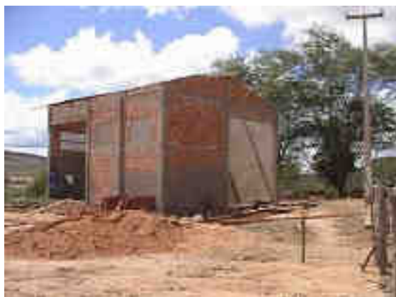
Galpão de Quixabeira em construção Fonte: COEP
