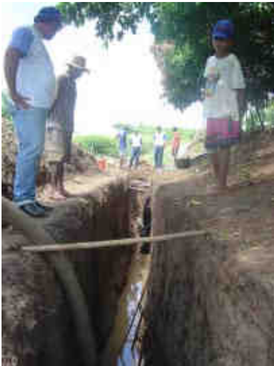
Construção de barragem subterrânea Fonte: COEP
