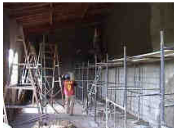
Galpão de Lagoa de Dentro em construção Fonte: COEP
